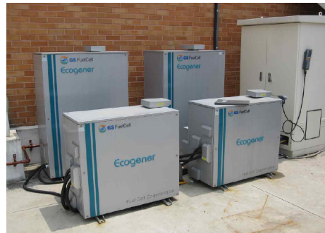
[그림 3-3] 가정용 연료전지 사용자 설치 사진
