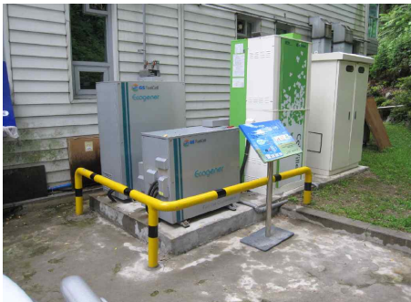
[그림 3-3] 가정용 연료전지 사용자 설치 사진
